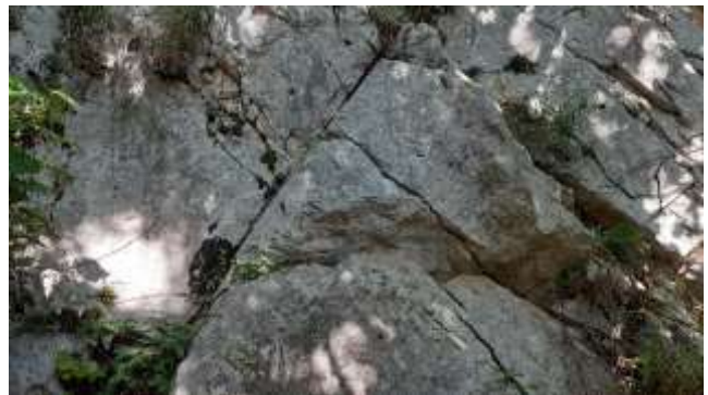
Calcari con presenza di sistemi di giunti
